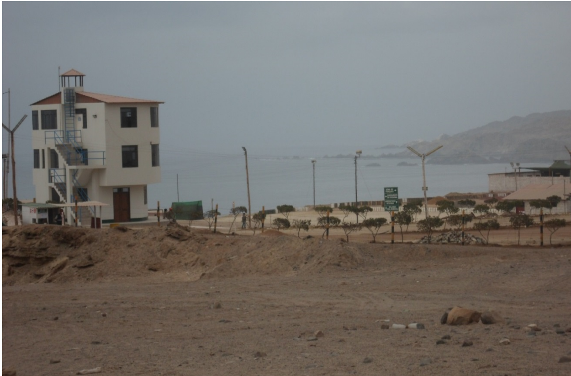
Fotografía 35 – Torre de Control de una Mina, a la Orilla de la Playa, en Chala, Arequipa
