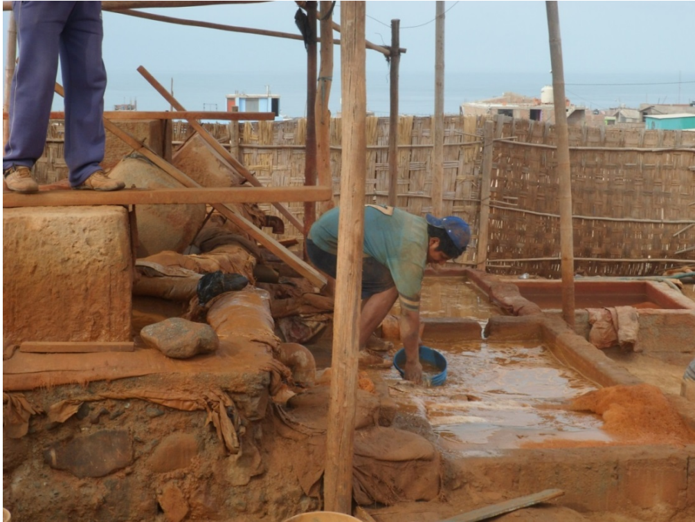
Fotografía 39 – Trabajador Manipulando con sus Manos Desnudas, el Agua Contaminada con Mercurio, en Quimbalete, Chala
